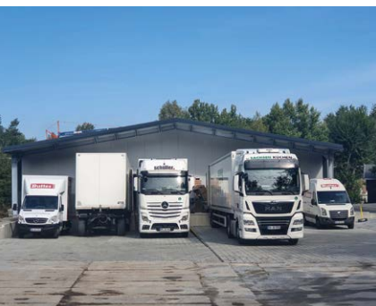
Marco Butter führt das Lager und die Montage, das Gebäude liegt außerhalb von Dresden direkt an der Autobahn und in Nähe des Flughafens.
